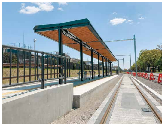
▶グリーンスタジアム前停留所も間もなく完成
