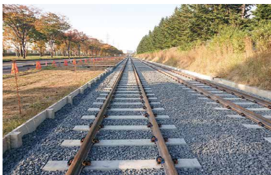
▶レール敷設工事も着々と
